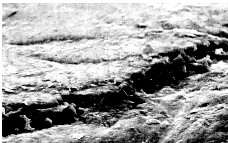
Рис. 1. Отрыв фрагмента покрытия из-за недостаточной прочности сцепления с подложкой ( \times 2000 )
